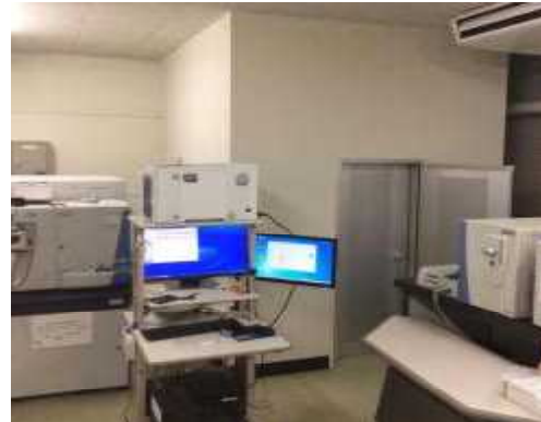
304号室遮音室（二重扉構造となっている）
