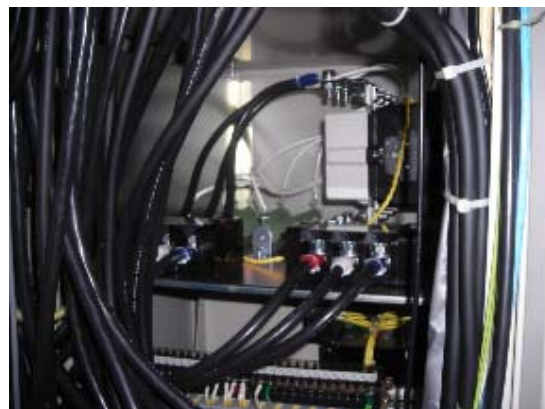
図 3 クライストロン・モジュレータに組み込まれた突入電流抑制ユニット。
