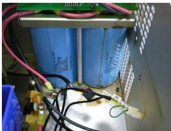
図 1 直流電源に取り付けられたフィルターキャパシターの液を漏れた模様
