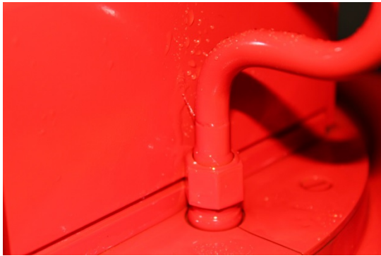
図3 漏水個所の拡大。パイプの溶接部に開いたピンホールから入力空洞側面に向けて冷却水が噴出している。
