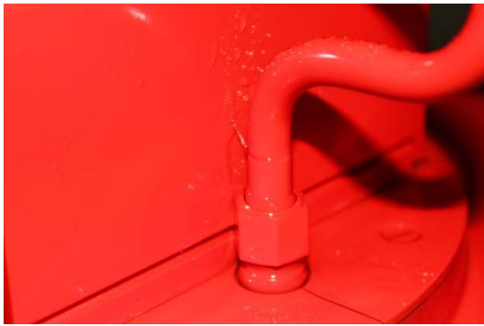
図3 漏水個所の拡大。パイプの溶接部に開いたピンヒールから入力空洞側面に向けて冷却水が噴出している。
