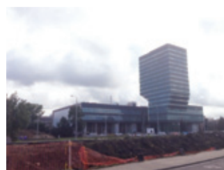
建設中のimec5
