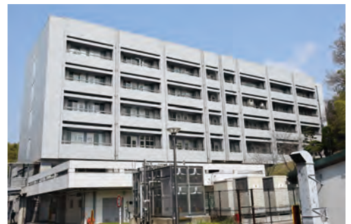
インキュベーション棟 全景
