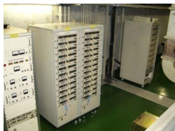
高周波システム・電磁石電源
